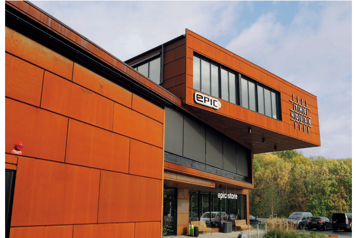
I Hovås söder om Göteborg finns kontorsbyggnaden Primo som är försedd med Cor-Ten . Fasaden har en vacker patina från stålets olika korrosionsfaser.
